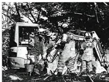
バケツで土砂を運搬(輪島市久手川)
