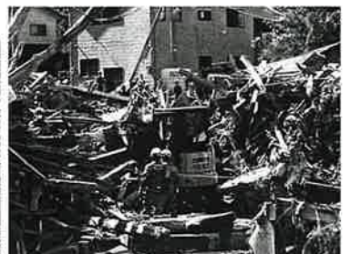
重機を使用しながらの捜索(輪島市町野町)
