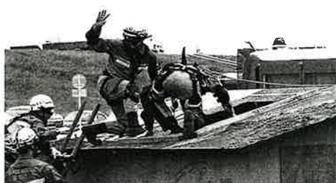
カッターで開けた侵入口から中の要救助者に呼びかける
